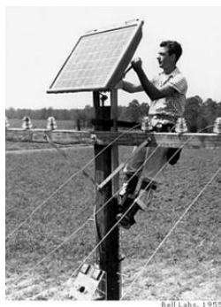
Figura 3 - Instalação da primeira célula fotovoltaica em Americus
